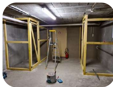
Réalisation de locaux de rangement au presbytère
