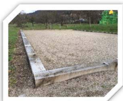
Réfection du terrain de pétanque
